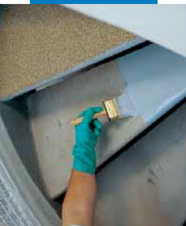
Aplicación de Mapecoat I 24 sobre hormigón
