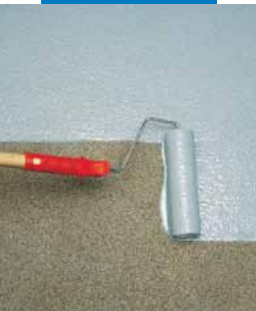
Aplicación de Mapecoat I 24 a rodillo
